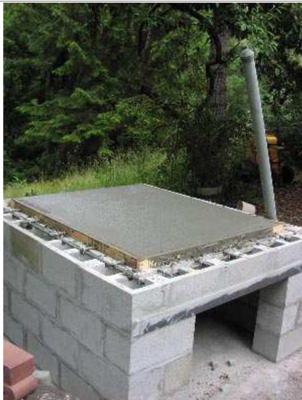
Letto di argilla mista a sabbia per alloggiare il piano del forno realizzato in mattoni. Notate che la cornice di legno è stata rimossa e adesso il basamento in cemento " galleggia" in uno spazio che lo isola termicamente dall'esterno.
