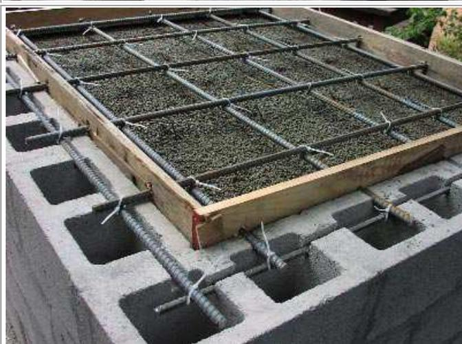
Basamento in cemento del forno completato. Il palo metallico sullo sfondo è stato utilizzato come 'spianatore' per ottenere una superficie perfettamente piana e livellata.
