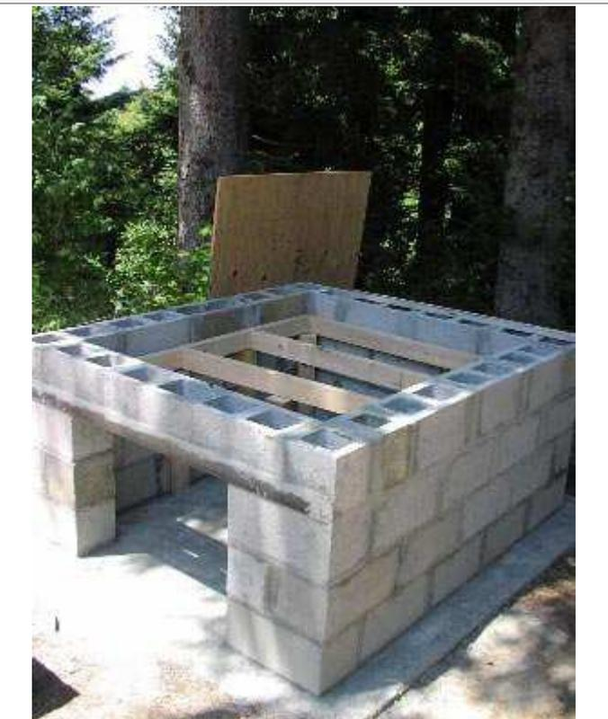
Piano di compensato. Questo piano può rimanere nel forno indefinitamente. Può essere rimosso nel caso occorra spazio sotto il forno, tuttavia fornisce un piccolo sostegno al forno stesso.
