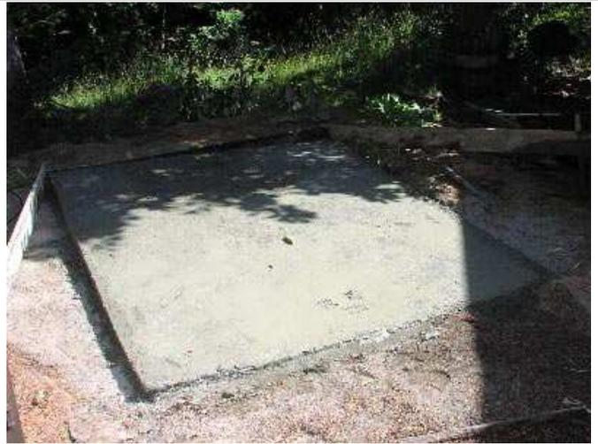
Costruzione del basamento con blocchi di cemento. I fori dei blocchi sono stati successivamente riempiti con malta di cemento e barre di ferro per cemento armato poste in verticale.
