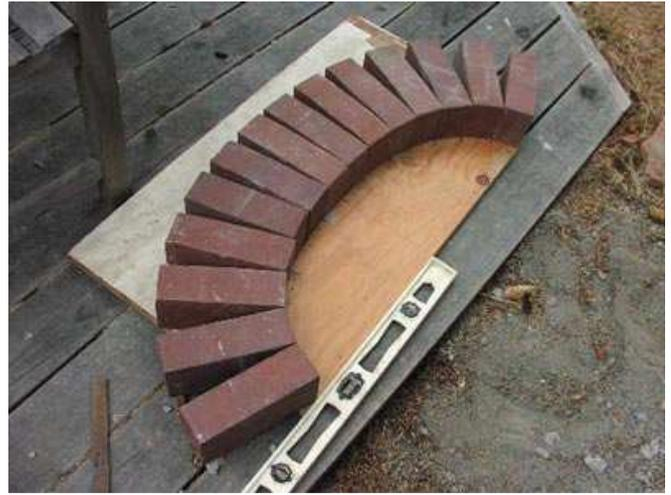
Completamento della volta verso il camino. La forma in legno per l'arco della porta al suo posto. Per sostenere i mattoni che chiudono la volta è stato usato un angolare di ferro.
