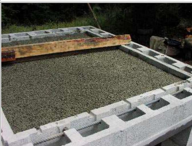
Tondi per cemento armato posti in loco e legati. Notate gli incassi nei blocchi di cemento. Sono stati realizzati con uno scalpello da muratore. La forma in legno verrà rimossa più tardi, lasciando uno spazio fra i blocchi e il piano del forno. I tondi di ferro devono essere esattamente al centro dello strato di cemento che verrà gettato appresso.
